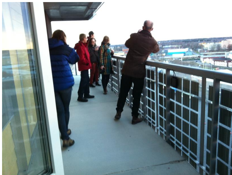
Figur 4. Några av deltagarna vid studieresan befinner sig på Fullriggarens balkong vars räcken utgörs av solceller.
