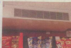
Tack vare kylans i bergvärmehuset leverar den här släkten kallluft under sommarhalvåret.
